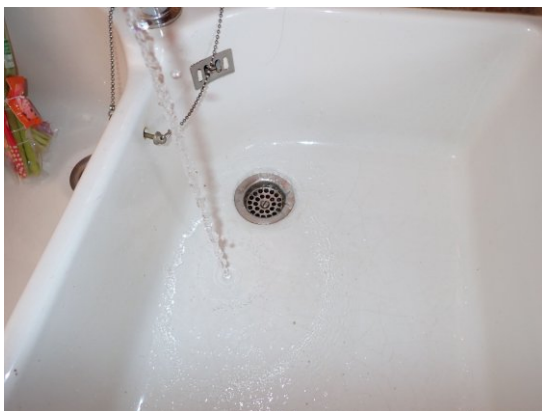
Vady a poruchy povrchů stěn a podlah
